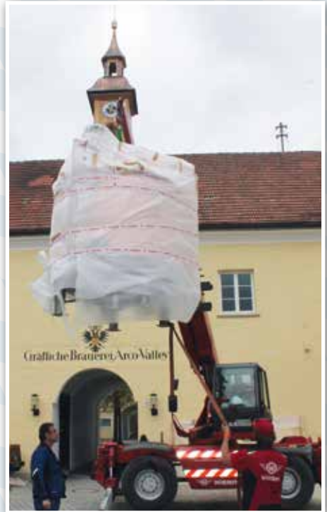
Der neue Läuterbottich wird vom Transport-LKW gehoben
