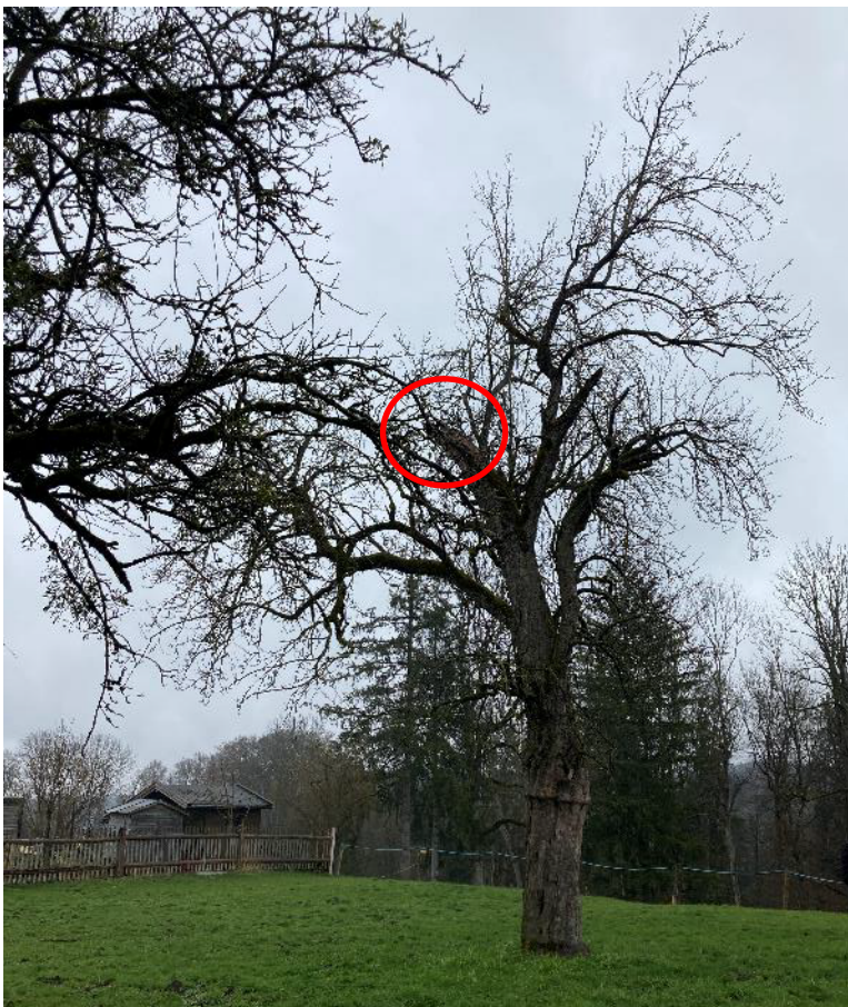
Abbildung 6: Baum 2 mit abgebrochenem Hauptstamm (roter Kreis), Blick von Südwesten.
